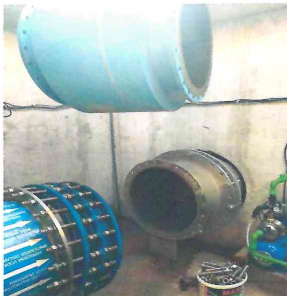
Slika 3. Pripremni radovi na skidanju postojećeg i ugradnji novog mjerača protoka vode
