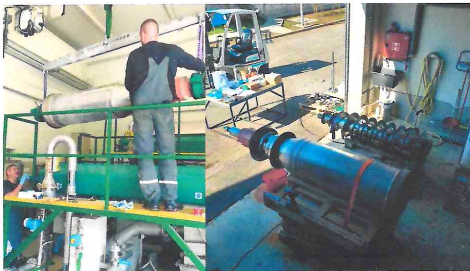
Slika 4. Početak radova na servisiranju centrifuge
