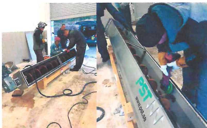
Slika 8. Pripreme za montažu novog pužnog transportera
