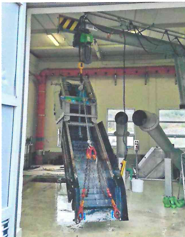
Slika 9. Vađenje rešetke iz ustave za potrebe servisa
