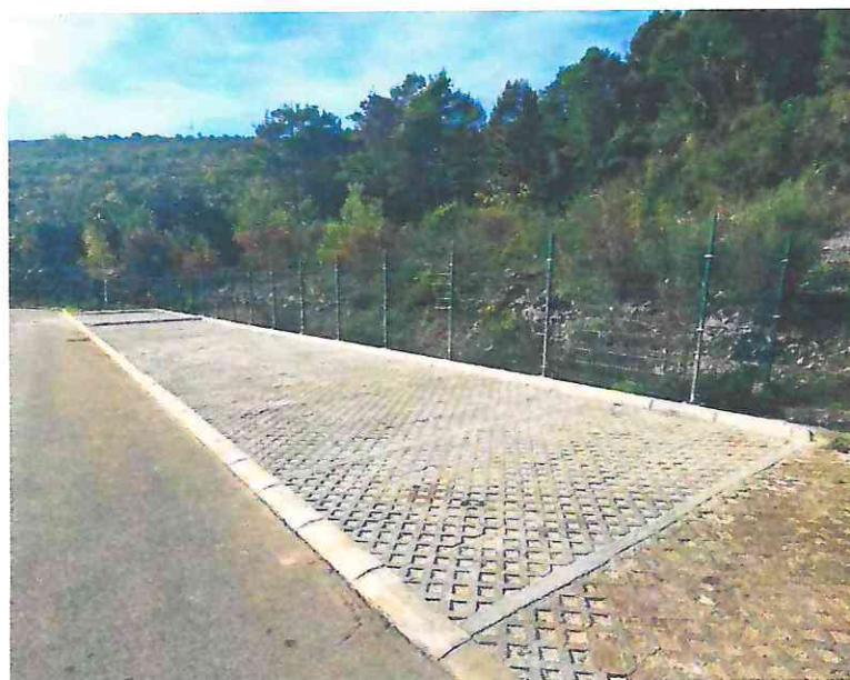
Slika 11. Proširenje parking mjesta pored upravne zgrade
