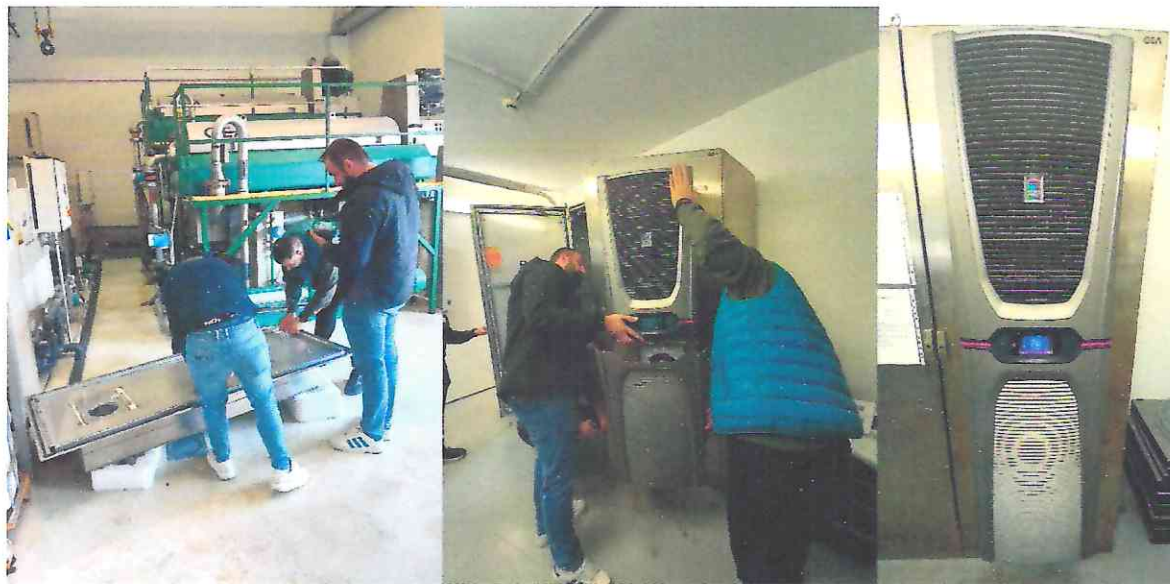
Slika 10. Demontaža starog i montaža novog rashladnog modula
