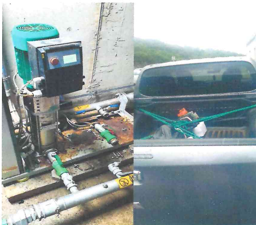
Slika 2. Radovi na demontaži pumpi i njihov transport
