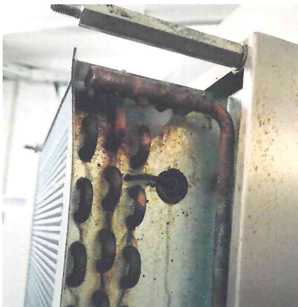
Slika 1. Saniranje curenja gasa na rashladnom modulu
