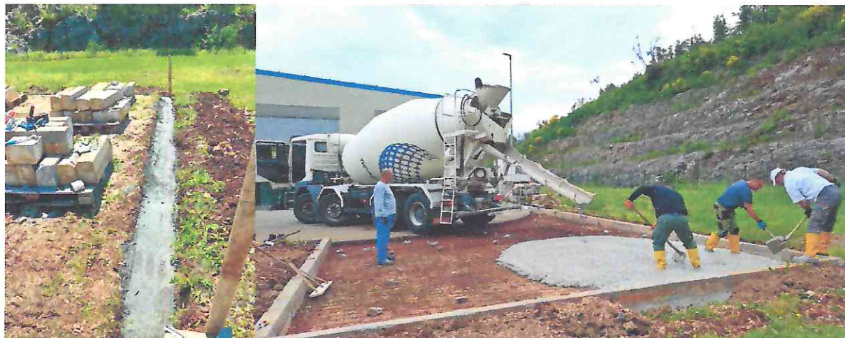
Slika 3. Priprema terena, postavljanje ivičnjaka i izlivanje platoa
