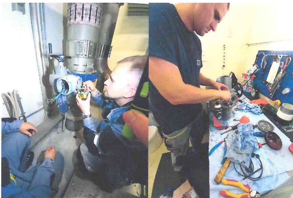
Slika 4. Demontaža i servis AUMA pogona
