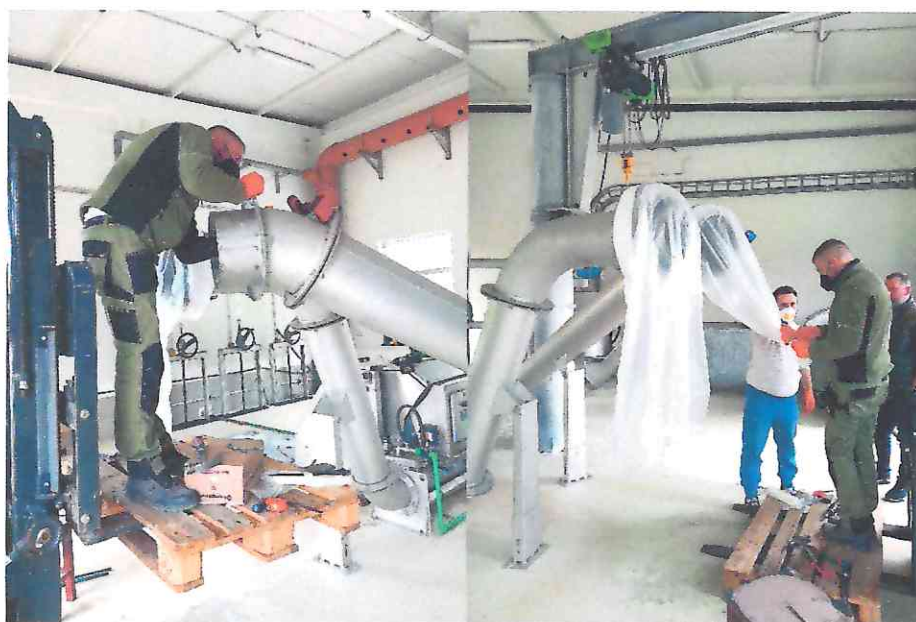
Slika 9. Radovi na montaži i izgled montiranih uređaja za uvrećavanje
