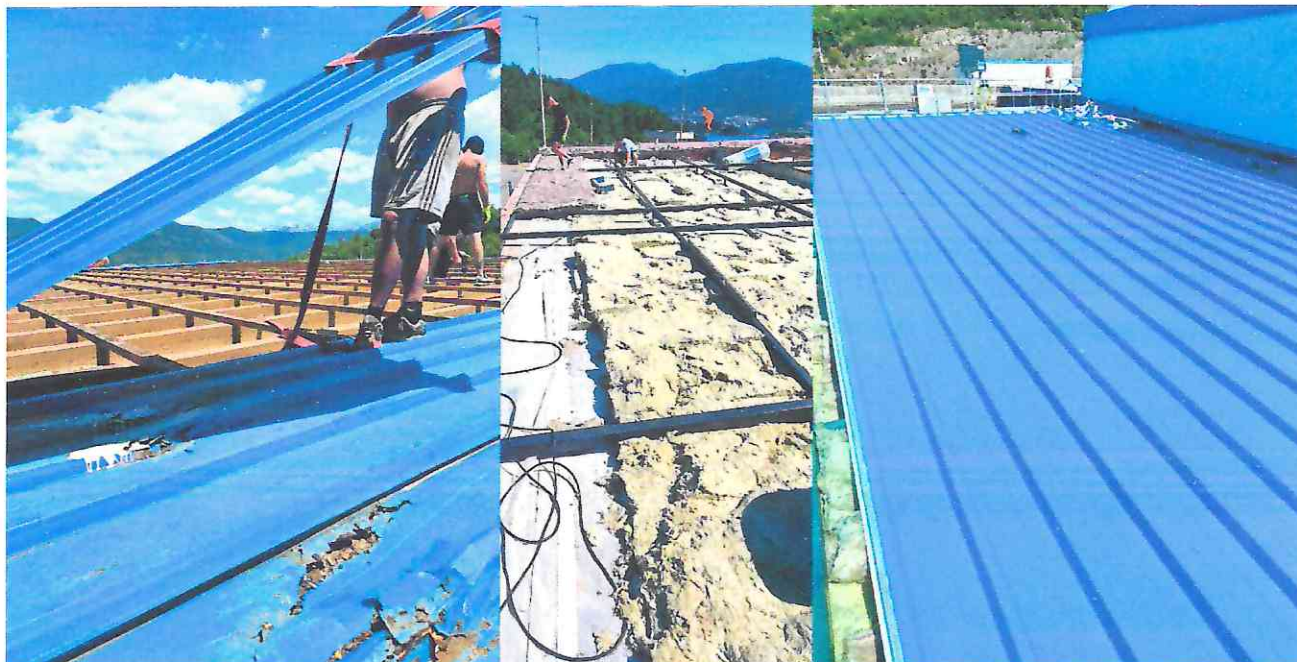
Slika 6. Skidanje oštećenog starog krovnog pokrivača, dodavanje dodatne termoizolacije i novi krovni pokrivač
