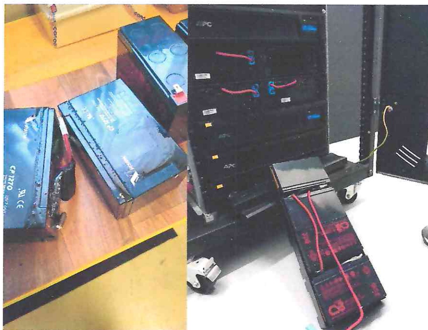
Slika 8. Oštećenje na starim i zamjena novim baterijama
