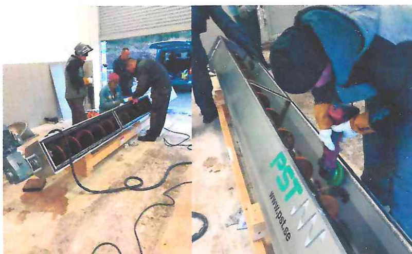
Slika 8. Pripreme za montažu novog pužnog transportera
