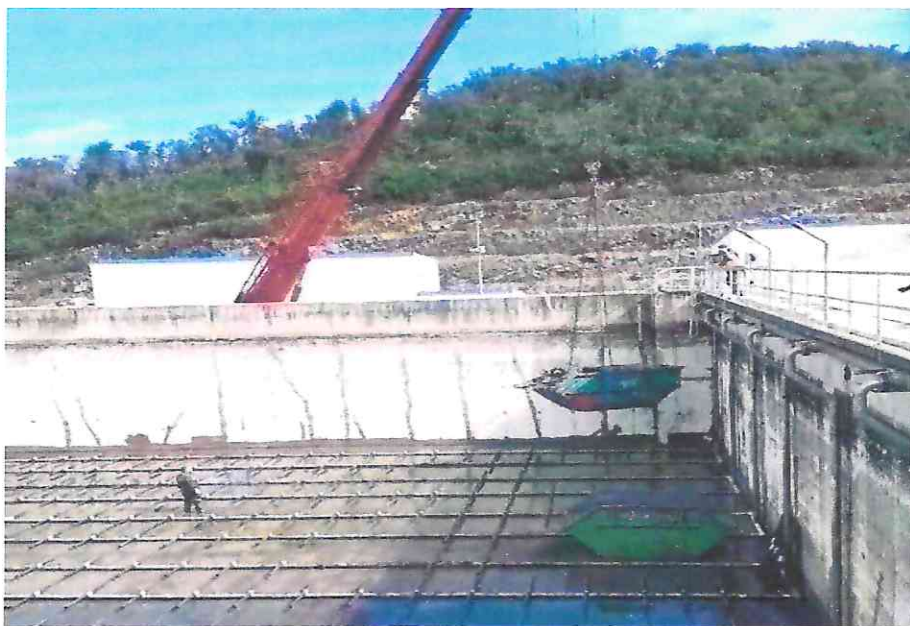
Slika 1. Procedura čišćenja reaktora broj 3
