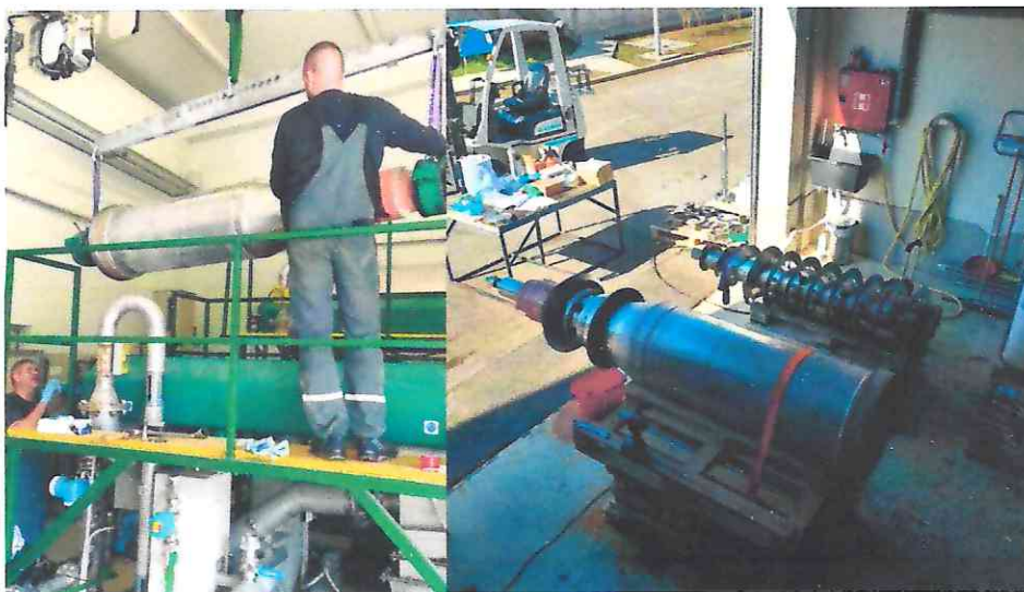
Slika 4. Početak radova na servisiranju centrifuge
