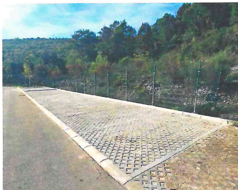
Slika 11. Proširenje parking mjesta pored upravne zgrade
