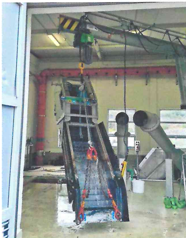
Slika 9. Vađenje rešetke iz ustave za potrebe servisa
